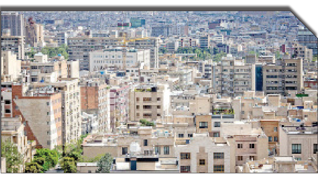
در ساخت و ساز خانه‌ها
